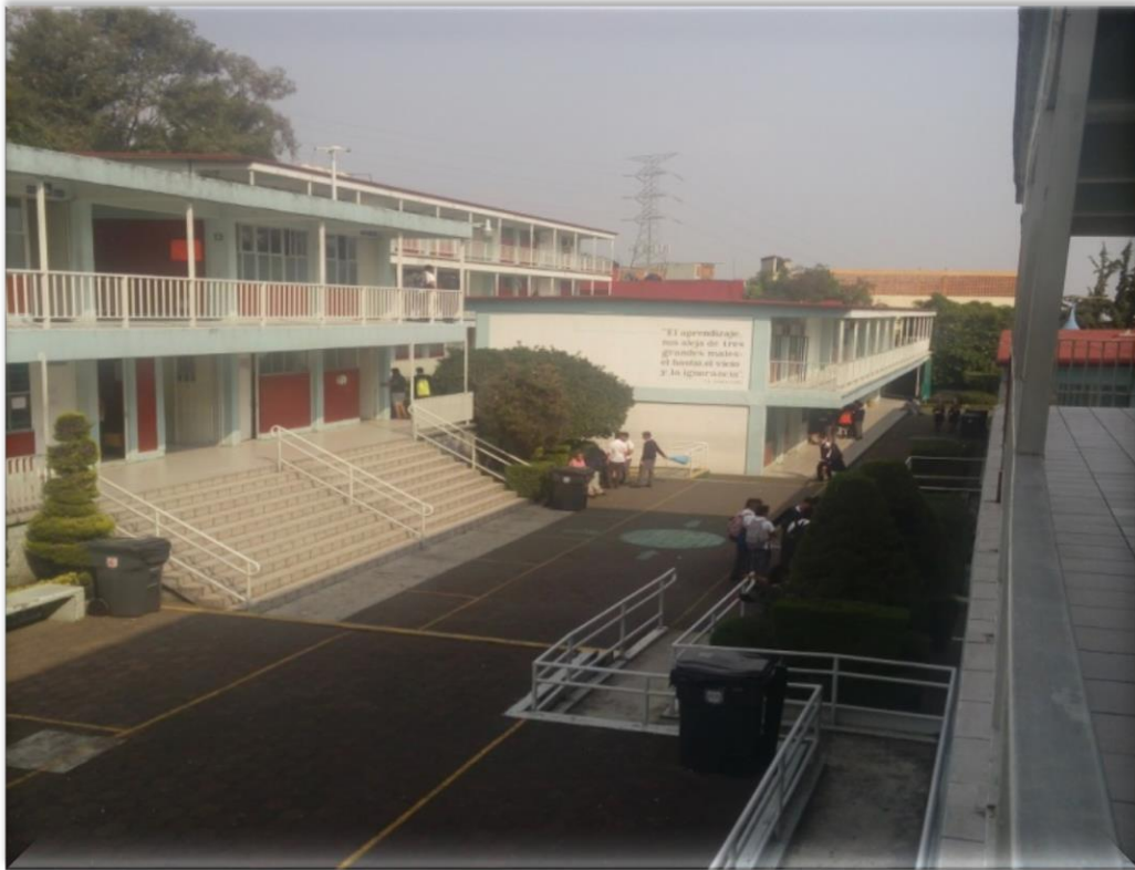
Ilustración 4. Instalaciones del CONALEP PLAMACO, Ciudad de México, 2015 (Fotografía de Maricruz Escobar Gil).
