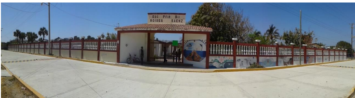
Fotografía 7. Fachada de la Escuela Primaria Bilingüe “Moisés Sáenz” de San Mateo del Mar, Oaxaca. Elaboración propia.
