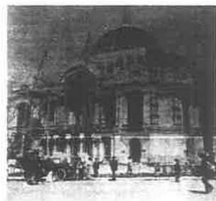
El Palacio de Bellas Artes en construcción (ciudad de México).
